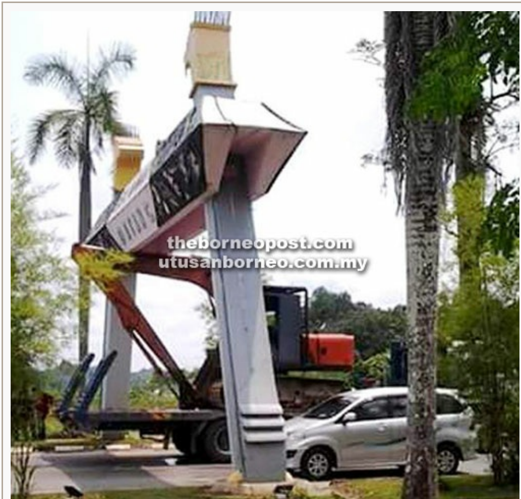
PUNCA: Jengkaut tersangkut pada pintu gerbang pada minggu lalu menyebabkan keretakan pada binaan tersebut.
